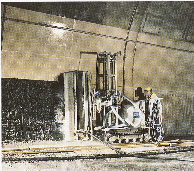
Bild 5. Hydrodynamischer Betonabtrag beim Ausbautyp A
