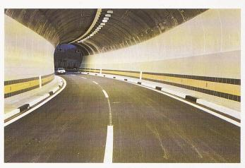
Bild 11. Erhöhung der Verkehrssicherheit durch optisches Führungsband
