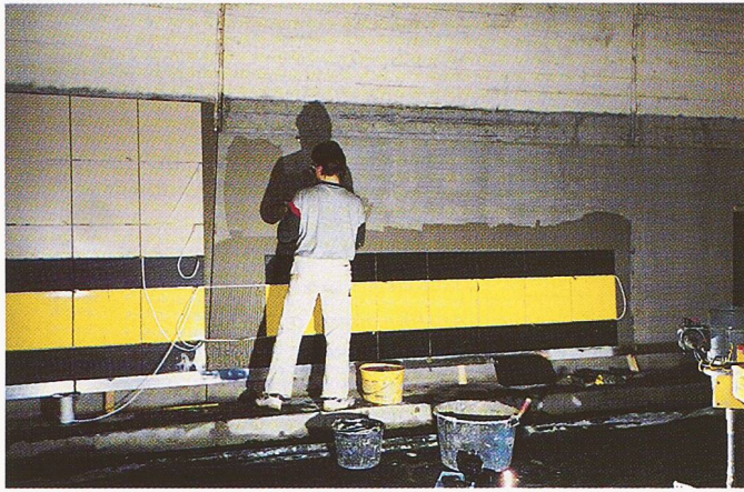
Bild 10. Aufziehen der Feinsteinzeugplatten
