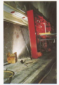
Bild 9. Abdichtung mit Noppenfolie, PVC-Dichtungsprofil mit Vibrieröffnungen, Stahlschalung, Ausbautyp D
