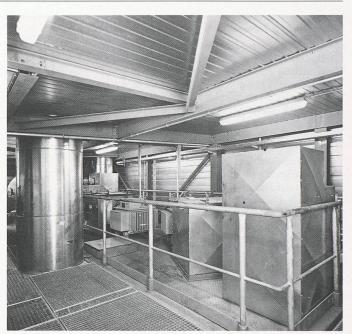
Bild 4. Oberer Teil des Elektrofilters mit Hochspannungsteil
