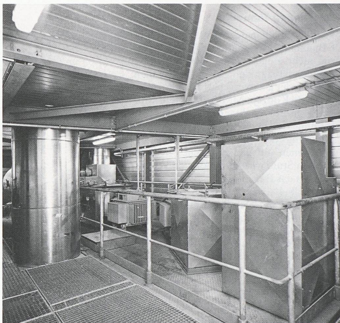
Bild 4. Oberer Teil des Elektrofilters mit Hochspannungsteil
