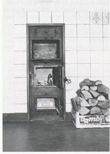
Bild 4. Kachelofen «Standard», von der Stubenseite her betrachtet: einfacher grüner Kachelmantel und Warmhalterohr mit Messingtüre (links); Kachelofen «Standard», Küchenseite: schwarze Metallfront mit Kochrohr (oben), Feuerraum mit Metallrost (Mitte) und Ascheschublade (unten). Zuluftregulierung über die «Rosetten» in den beiden unteren Türen (rechts).
