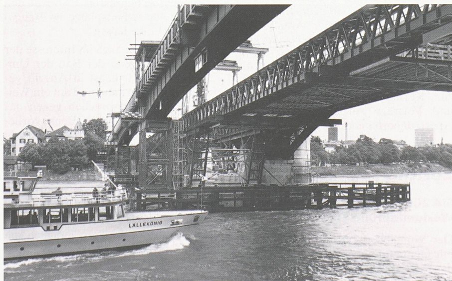
Die Hilfsbrücke links übernimmt während der Bauzeit der Basler Wettsteinbrücke den Autoverkehr. Deutlich sichtbar um den Brückenpfeiler: der Ramm-schutz gegen Schiffskollisionen (Bild: Comet)
