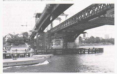
Die Hilfsbrücke links übernimmt während der Bauzeit der Basler Wettsteinbrücke den Autoverkehr. Deutlich sichtbar um den Brückenpfeiler: der Rammschutz gegen Schiffskollisionen (Bild: Comet)
