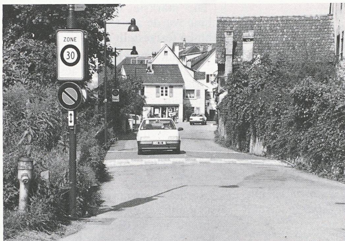
Bild 1. Aufpflasterung
