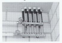
Alle wasserführenden Systemteile aus korrosionsbeständigem Rotguss
