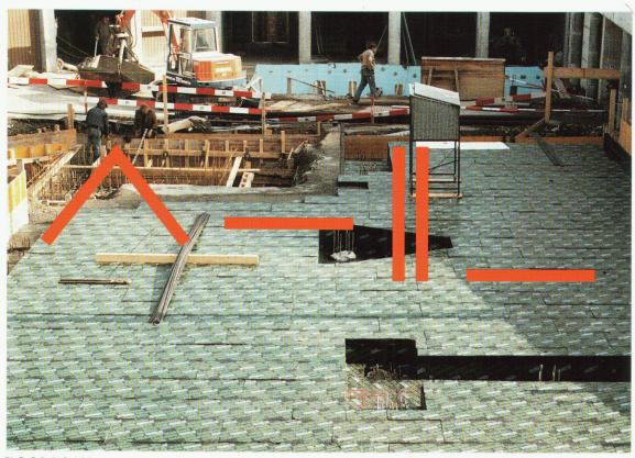
FOAMGLAS®-FLOOR BOARD, eine Weiterentwicklung von Pittsburgh Corning für die Bodendämmung in Trockenbauweise (im Bild die Verlegung von FOAMGLAS®-FLOOR BOARD unter der Bodenplatte eines Wohngebäudes).
