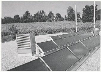
Bild 1. Sonnenenergie im industriellen Prozess: Die 31,5 m<sup>2</sup> Kollektoren liefern Wärme in die Bäder der Vorbehandlung (Alle Fotos: Ernst Schweizer AG, 8908 Hedingen)
