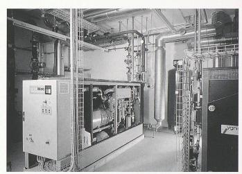
Bild 2. Gut integriertes Blockheizkraftwerk: 290 MWh Strom fliessen in Antriebe und Beleuchtungen, 580 MWh Wärme heizen die Bäder der energieintensiven Lackiervorbehandlung. Zur Deckung von Bedarfspitzen kommt der Propangas-Kessel zum Einsatz
