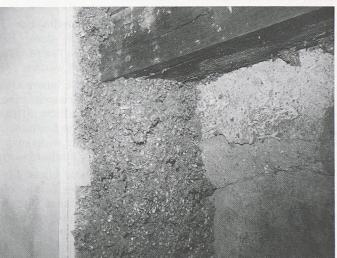
Bild 9. Einfamilienhaus Winterthur: Probeöffnung an der Aussenwand; kompakte, dichte Anschlüsse der Zellulosefasern
