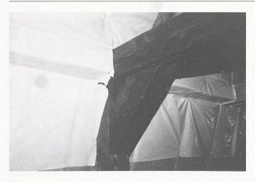
Bild 1. Systembedingte Undichtigkeiten in der Luftdichtigkeits- und Dampfsperrschicht bei den Durchstossstellen der Zangen
