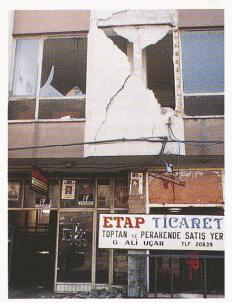
Bild 12. Dreigeschossiger Stahlbetonskelettbau mit Mauerwerk auf Deckenvorsprung. Mauerwerk mit X-Rissen, nicht als Ausfachung konzipiert
