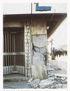
Bild 10. Schubbruch einer ungenügend bewehrten Randstütze eines dreigeschossigen Eckgebäudes
