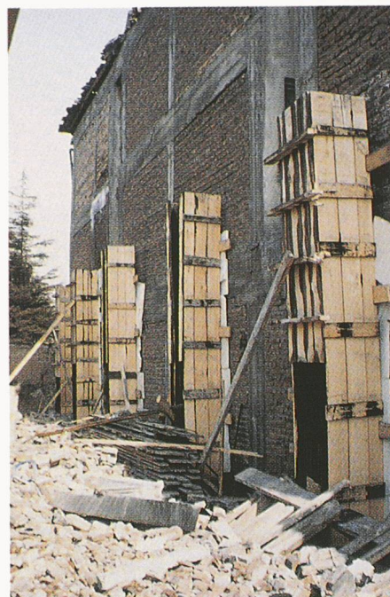
Bild 6. Dreigeschossiger Stahlbetonskelettbau, mit Modul-Backsteinen ausgefacht, ohne Schäden in der Tragstruktur
