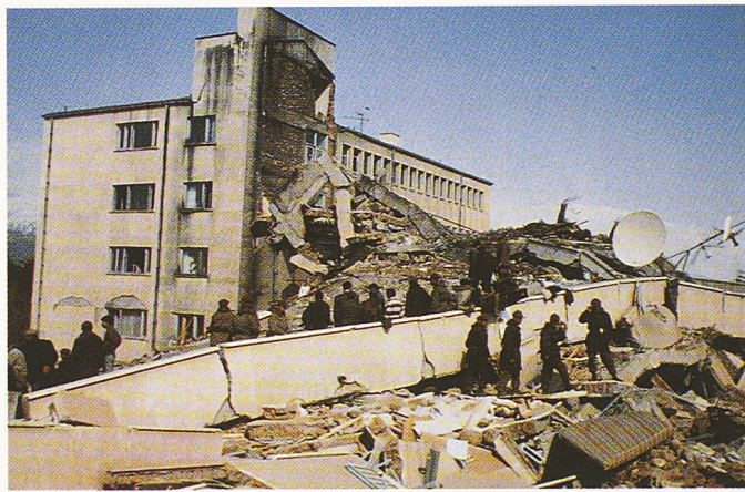
Bild 8. Richtung NNW eingestürzter, fünfstöckiger, L-förmiger Stahlbetonskelettbau eines Spitals in Erzincan
