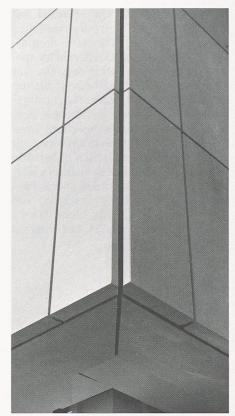
Bild 3. Detail Eckverkleidung mit Gehrung. Gesamthaft wurden gegen 3000 Sandsteinplatten unterschiedlichen Formates versetzt
