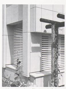
Bild 2. Detail profilierte Eckpfeilerverkleidung. Hinter den 5 cm starken Sandsteinplatten liegen ein 3 cm weiter Spalt zur Luftzirkulation und eine 8 cm dicke Wärmedämmschicht aus Glaswolle
