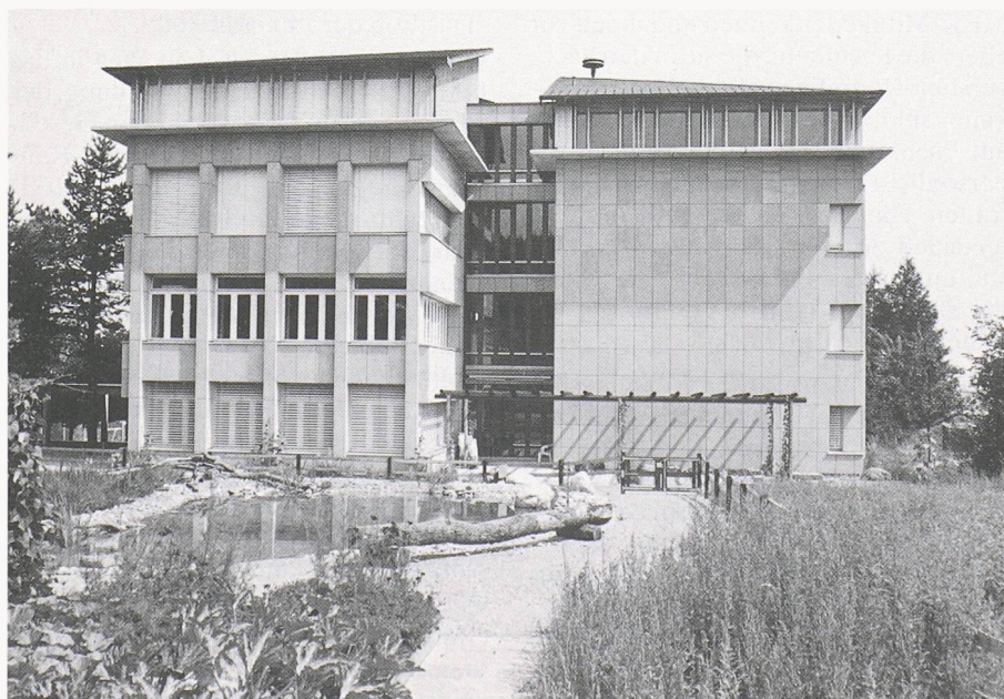
Bild 1. Sanierte und aufgestockte Schulanlage Bommern in Pfaffhausen, ZH. Erstmals wurde an diesem Bau eine grossflächige, hinterlüftete Fassade aus Schweizer Sandstein-Platten versetzt (Fotos: Pro Naturstein/Stadler)
