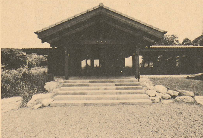
Der Kindergarten Egliswil AG zeigt das Prinzip der selbsttragenden Leichtkonstruktion für grossräumige, helle und offene Gemeinschaftsbauten besonders deutlich
