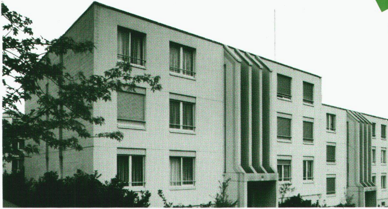
Total vorfabriziertes Mehrfamilienhaus "Morgental" in Dällikon.
