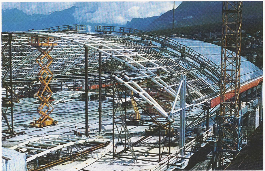
Bild 14. Montagezustand Hallendach
