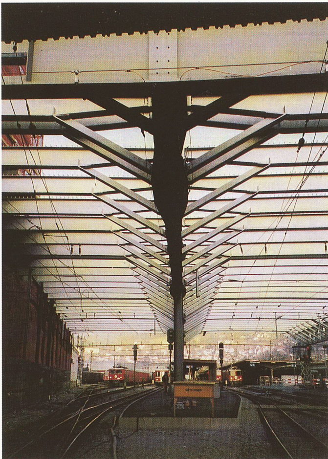
Bild 10. Das Postautodeck im Bau
