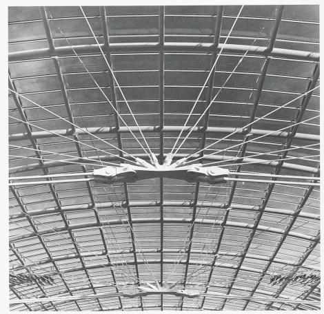
Bild 12. Verknüpfung der Zugbänder des Hallendachs
