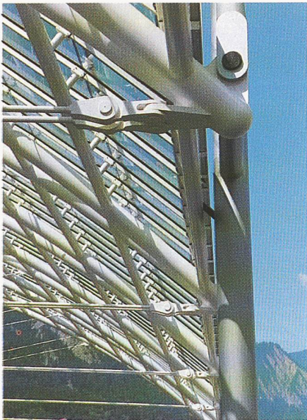
Bild 13. Anschlussdetail Zugbänder und Aufständigung Dachhaut
