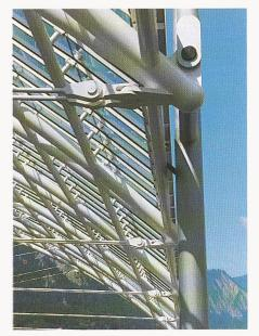
Bild 13. Anschlussdetail Zugbänder und Aufständerung Dachhaut
