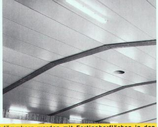
Wilan-Deckenwärmedämm-Fertigbauelemente mit Hochwärmedämmkern werden mit Fertigoberflächen in den verschiedensten Materialien produziert, zum Beispiel: mit Dünnspanplatten, mit Kunststoffdeckschichten, mit Zementfaserplatten, mit Aluminiumfolien oder mit Fertigputzdeckschichten. Montage: auf alle Unterkonstruktionen auch zum Einlegen in Betonschalungen.
