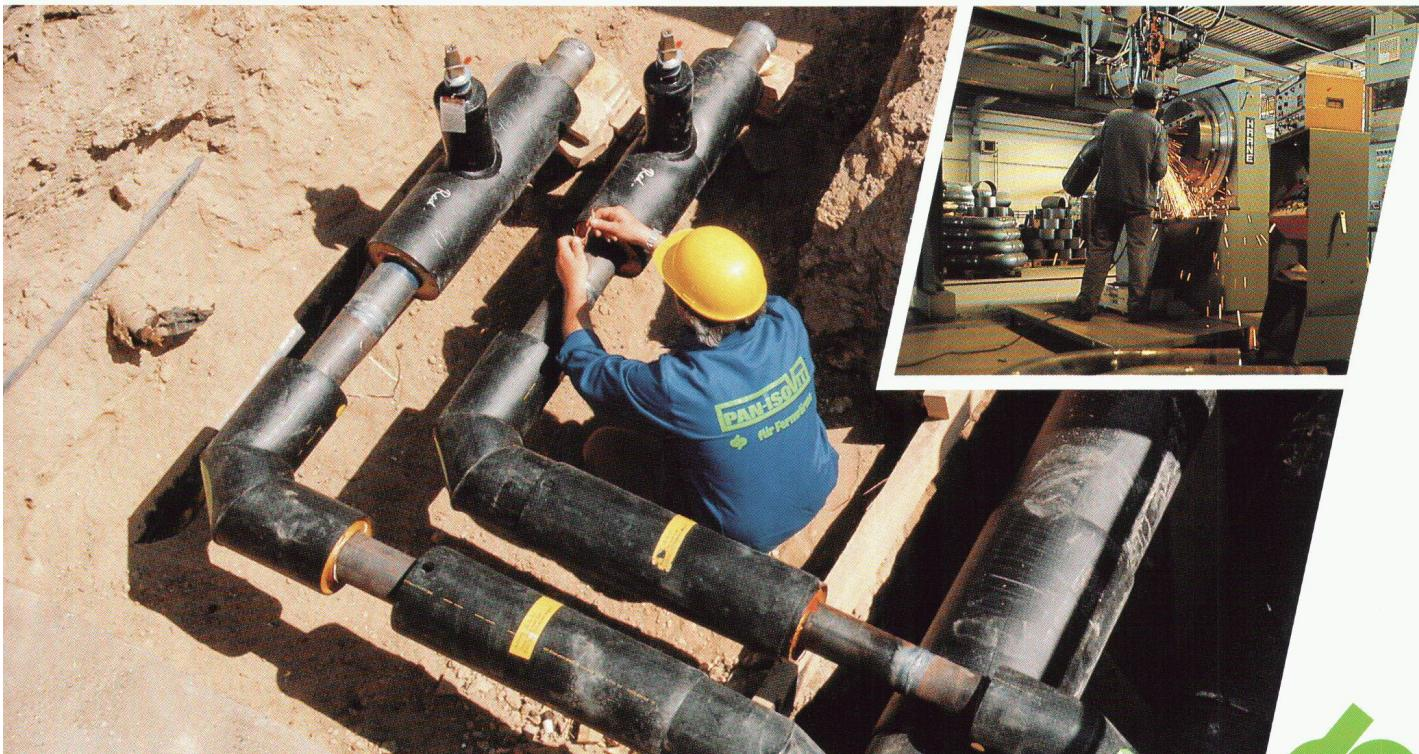
Bei Fernwärme-Systemen ist Sicherheit alleroberstes Gebot. Selbstverständlich sind die Rohre wichtig – entscheidend für die Sicherheit sind aber die Formteile. Hier geht's um die Wurst.
