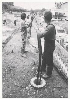
Bild 2. Einbringen der Wärmetauschersonden in einen Schleuderbeton-Hohlpfahl
