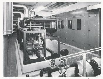
Bild 3. Gas- und Elektrowärmepumpe Wärmezentrale Brugg AG, Zeughaus: links Elektro-Wärmepumpe, rechts geschlossenes Schalldämmgehäuse der Gasmotor-Wärmepumpe (Foto: H. Studer, Postfach 47, 3000 Bern 11)
