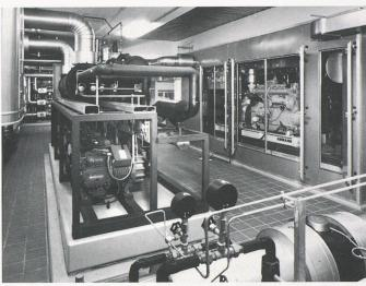
Bild 4. Gas- und Elektrowärmepumpe Wärmezentrale Brugg AG, Zeughaus: links Elektro-Wärmepumpe, rechts Gasmotor-Wärmepumpe (Foto: H. Studer, Postfach 47, 3000 Bern 11)
