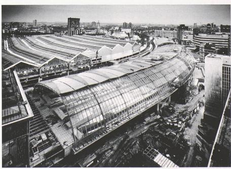
Die Bauarbeiten am neuen Bahnhof Waterloo International, Londons Tor für den Eisenbahnverkehr zum Kanaltunnel, sind bereits weit fortgeschritten. Durch ein grosses Glasdach wird das Halleninnere mit Tageslicht erhellt
