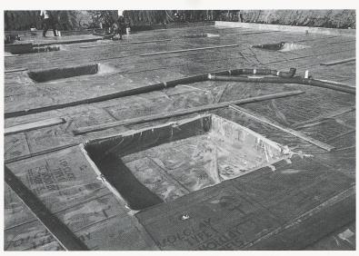
Abdichtung einer grossen Baugrube mit Volclay-Tafeln
