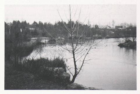
Bild 7. Büsisee als Regenrückhaltebecken an der Zürcher Nordumfahrung mit Dauerstau (Grundsee mit gestalteten Ufern)
