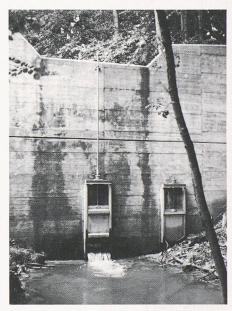
Bild 6. Hochwasserrückhaltebecken Ottenhusen. Luftseite der Wildbachsperre mit Durchlass (links) und Notöffnung (rechts)
