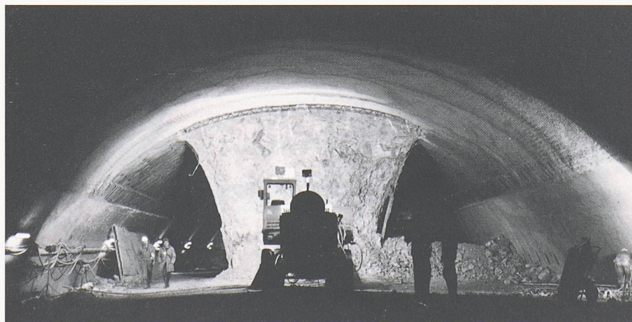
Bild 6. Kalottenvortrieb in der Verzweigung
