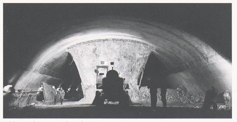
Bild 6. Kalottenvortrieb in der Verzweigung
