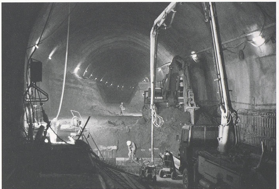
Bild 7. Strossenabbau und Sohlgewölbe in der Molasse
