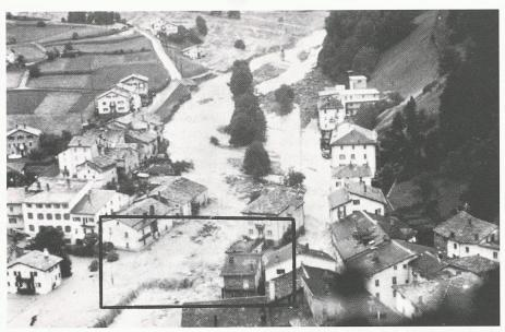
Bild 1. Feststoffablagerungen im Gerinne des Poschiavinos oberhalb der Cimavilla-Brücke am 18./19. Juli 1987. Hochwasserabfluss über die Kantonsstrasse gegen die Via Maestra (Foto A. Riedo, Poschiavo)
