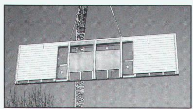
Ein vollinstalliertes HP-Makro-Baumodul wird vom Kran auf den Montageplatz gehoben.
