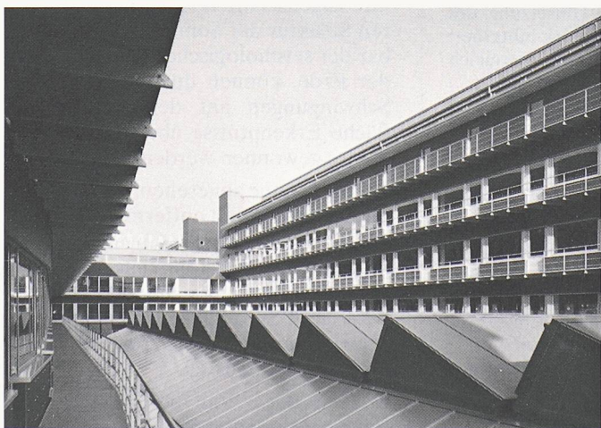
Im Technopark Zürich: Zwischen den Längstrakten liegen eingeschossige Werkhallen mit Oberlichtern. Die Balkone längs der Gebäudefassaden dienen als Fluchtwege, was den einzelnen Geschossen optimale Belichtung sowie grosse Gestaltungsfreiheit ermöglicht. Rechts: Grundriss 2. und 3. OG
