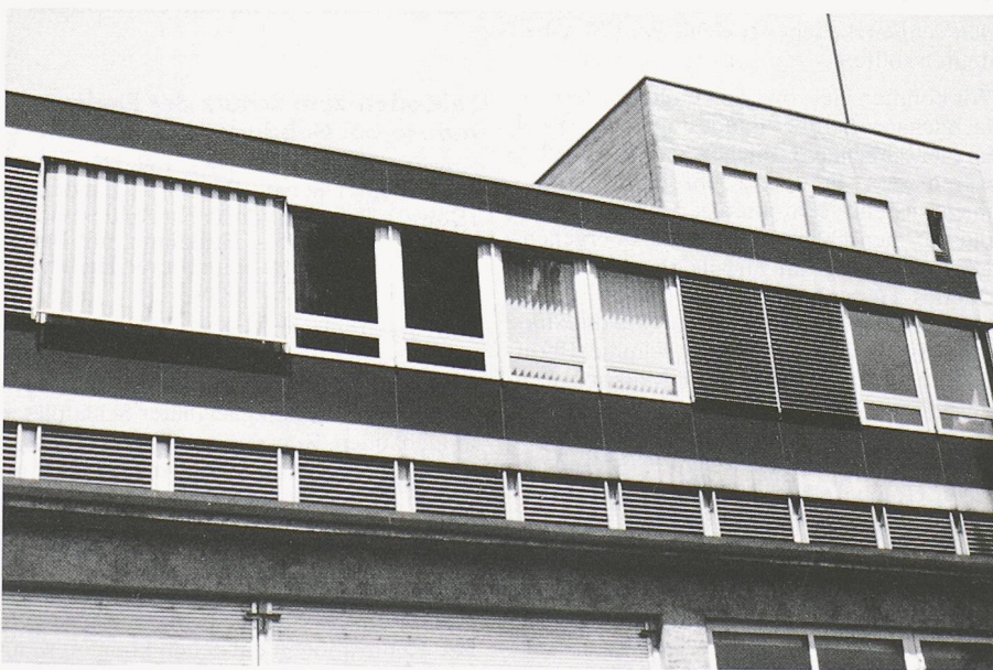
Aussenansicht der Büroräume, in welchen klima- und lichttechnische Messungen durchgeführt wurden. Von links nach rechts: Stoffstore; Absorptionsglas; Reflexionsglas mit vertikalen Stofflamellen innen; Lamellenstoren; Floatglas (für Vergleichszwecke).
