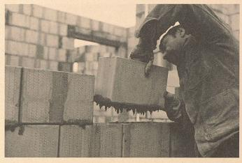
Der neue Tauchmörtel Lamitmur tuffa erlaubt eine rationelle Mauerwerkserrichtung
