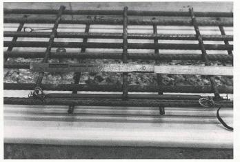
Bild 3. Der Sensor im eingebauten Zustand vor dem Betonieren
