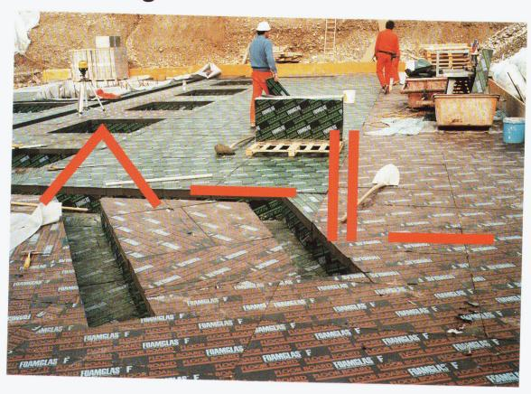
FOAMGLAS®-FLOOR BOARD, eine Weiterentwicklung von Pittsburgh Corning für die Bodendämmung in Trockenbauweise (im Bild die in Abhängigkeit der erwarteten Belastungen gemischte Verlegung von FOAMGLAS®-FLOOR BOARD und FOAMGLAS®-FLOOR BOARD F unter der Gründungsplatte eines Industriebaus).
