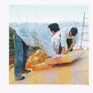
Nach dem Markieren wird der TAFIXE mit einigen Hammerschlägen in der Dämmschicht fixiert. Seine genau der Dicke des Dämmstoffs entsprechende Höhe sorgt für eine ausgezeichnete Ebenheit des Daches.
