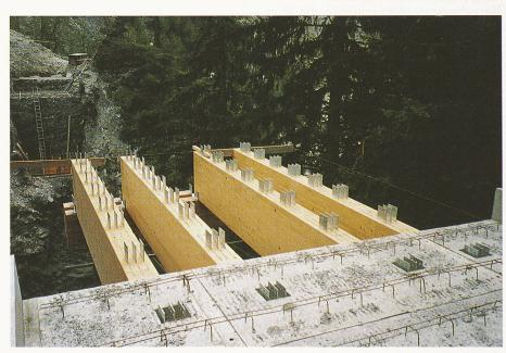
Erste Längsträger mit Schubdübeln sind montiert, die vorderste, 8 cm starke, als Schalung für die Fahrbahn dienende Betonplatte ist versetzt. Zu erkennen sind die Aussparungen für die Dübel
