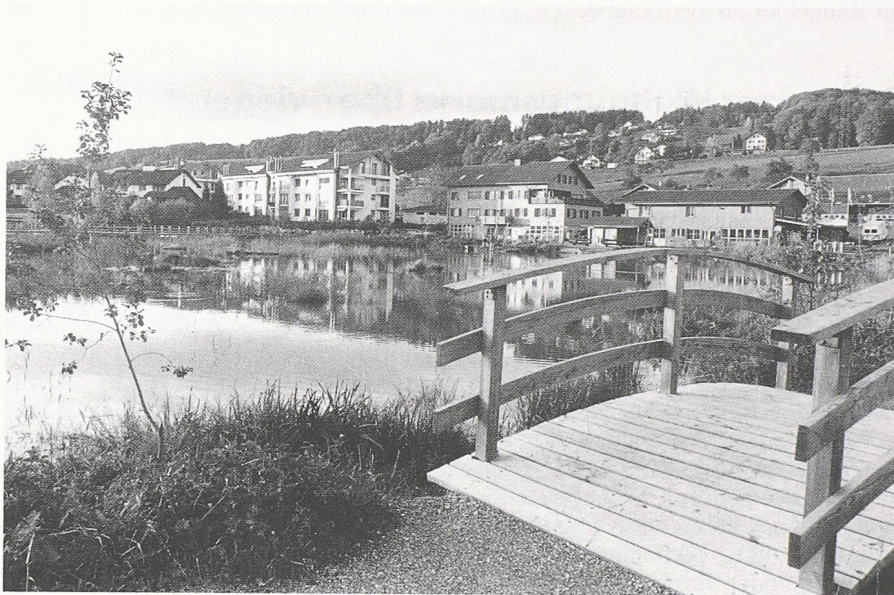
Bild 3. Das Eschenbacher Regenwasserrückhalte-Becken: für einmal nicht aus Beton, sondern als naturnaher Weiher und Naherholungsgebiet gestaltet (Bild: E. Krättli)
