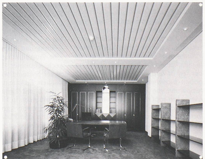
Bild 6. Chefbüro mit Kühldecke in einer Bank an der Zürcher Bahnhofstrasse. Bild: SBG
