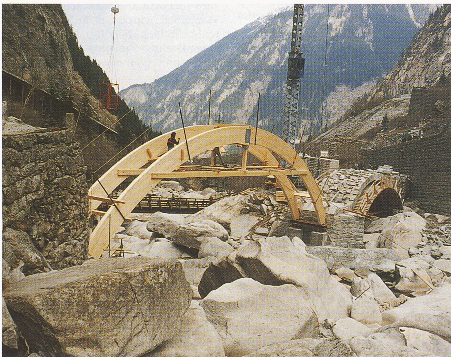
Bild 14. Montage des Lehrgerüsts für den grossen Bogen (Foto Aschwanden)
