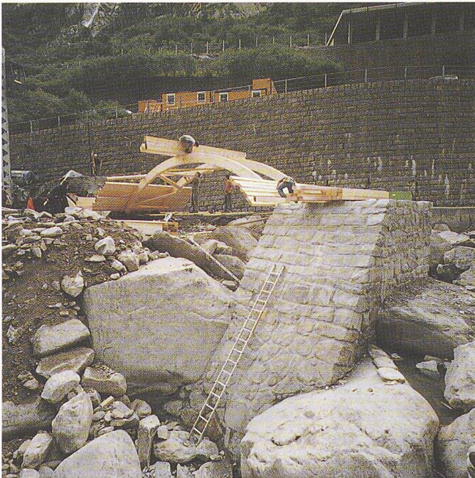
Bild 4. Hauptpfeiler auf drei Felsblöcken fundiert (Foto Aschwanden)
