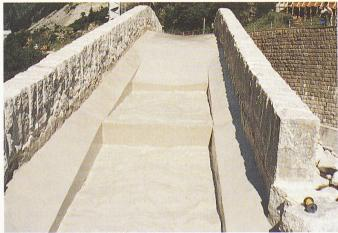
Bild 8. Detail Abdichtung (Foto P. Kurmann)
