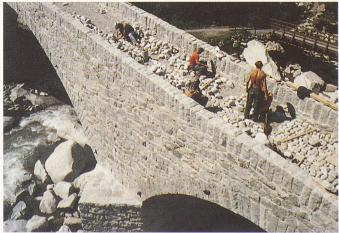
Bild 9. Einbau der Pflästerung aus gerundeten Steinen
