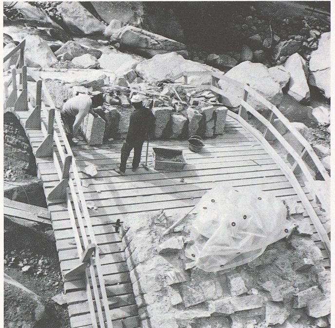
Bild 5. Mauern des mittleren Bogens mit stehenden Quadern (Foto Aschwanden)
