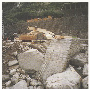
Bild 4. Hauptpfeiler auf drei Felsblöcken fundiert (Foto Aschwanden)
