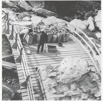
Bild 5. Mauern des mittleren Bogens mit stehenden Quadern (Foto Aschwanden)
