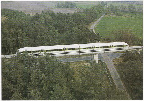
Bild 12. Kreuzungsfrei ausgebildeter Fahrweg der Magnetschnellbahn
