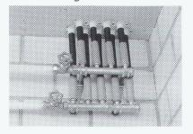
Alle wasserführenden Systemteile aus korrosionsbeständigem Rotguss
