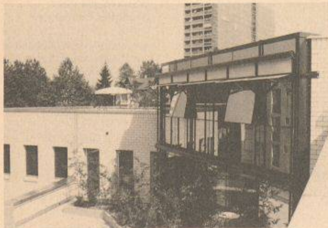
Die nachträglich angebrachte Tragkonstruktion für die Sonnenstoren beim SVB-Verwaltungsgebäude in Worblaufen BE
