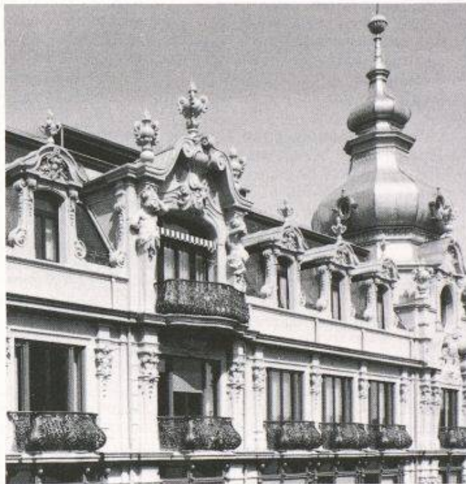
Die ursprünglichen Gussgeländer der Balkone wurden anhand von Fotografien aus der Jahrhundertwende in Aluguss rekonstruiert
