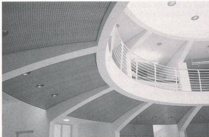
Die gewölbten Deckenelemente, die aus akustischen Gründen gelocht sind, konnten kostengünstig auf einem CNC-gesteuerten Bearbeitungszentrum realisiert werden (H. Herger, Altdorf)
