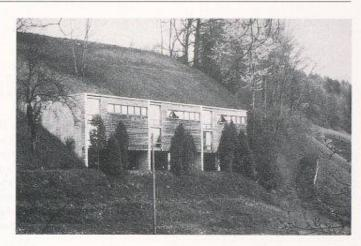
kennen: Holzkörper mit grossen Fensteröffnungen, besonders im Vergleich zu den Fenstern des Untergeschosses, das weit auskragende Dach, die Laubengänge und der Sockel für den Witterungsschutz der Aussenwand. Das Konstruktions- und Gestaltungsprinzip für die Anwendung von Holz und Stein lautet hier also: Leichtes auf Schwerem, Veränderbares und zu Schützendes zugänglicher als Ewiges und Unempfindliches.
