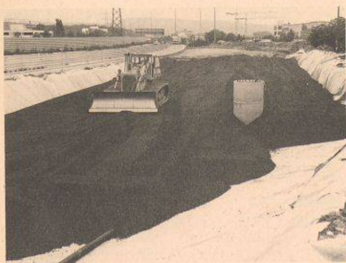
Leca-Blähton im Brüttseller Kreuz: Der setzungsempfindliche Baugrund unter der neuen Fahrbahn wird gegen bedeutend leichteres, aber dennoch mechanisch festes Leca von Hunziker Baustoffe ausgetauscht
