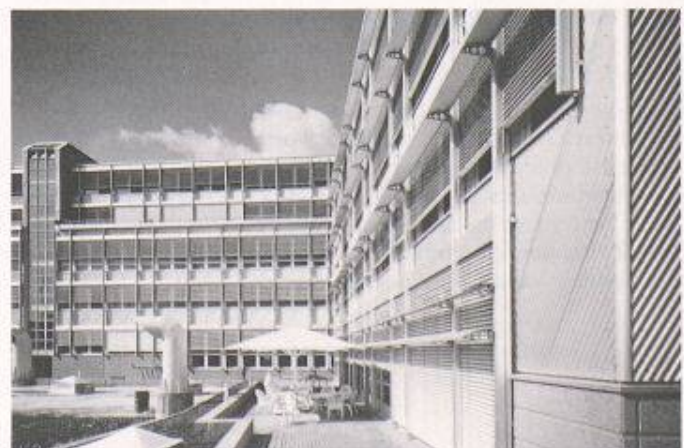
Bild 2. Büro- und Gewerbehau «Schwerzenbacherhof»
