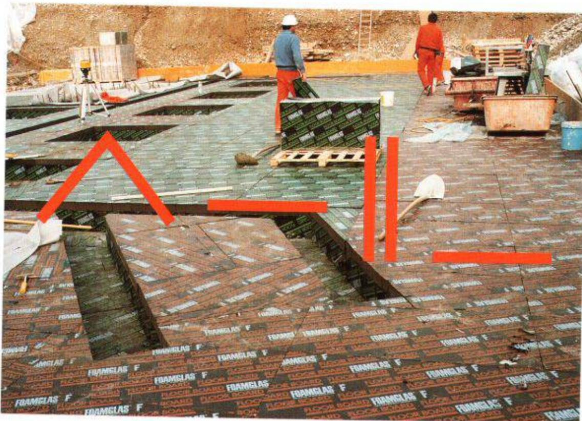
FOAMGLAS®-FLOOR BOARD, eine Weiterentwicklung von Pittsburgh Corning für die Bodendämmung in Trockenbauweise (im Bild die in Abhängigkeit der erwarteten Belastungen gemischte Verlegung von FOAMGLAS®-FLOOR BOARD und FOAMGLAS®-F unter der Gründungsplatte eines Industriebaus).
