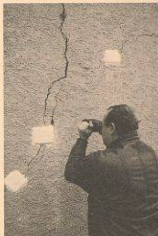
Schäden können mit einer Sofortbildkamera jederzeit festgehalten werden, ohne dass die Bauarbeiten unterbrochen werden müssen. Die Fotos werden auch von Versicherungen als Beweismittel akzeptiert
