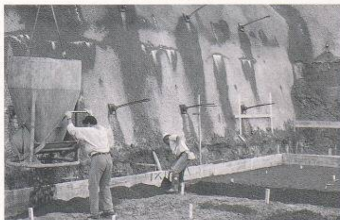
Bild 2. Blick auf die mit Felsankern und Stahlfasernassspritzbeton gesicherten Hangabschnitte
