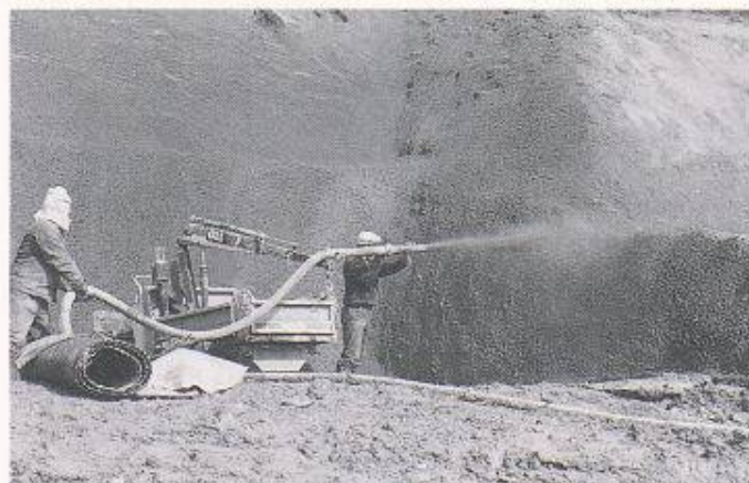
Bild 1. Terrassenbauweise mit Hangsicherung aus Felsankern und einer nur 12 cm dicken Schicht Stahlfasernassspritzbeton
