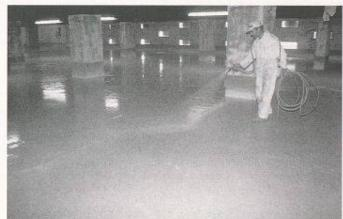
Bild 6. Rissüberbrückende Abdichtung von Bauteilen: Eine zentrale Bedeutung hat die Abdichtungsmembrane
