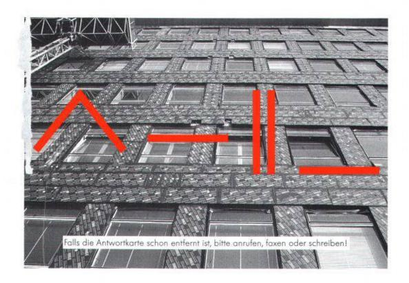
FOAMGLAS®-T5 und FOAMGLAS®-WALL BOARD, eine Weiterentwicklung von Pittsburgh Corning für die Dämmung von Vorhangfassaden und zweischaligen Wänden (im Bild der Einbau von FOAMGLAS®-WALL BOARD hinter einer vorgehängten Kunststeinfassade am Beispiel einer Fassadensanierung im Wohnungsbau).
