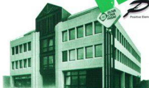
Geschäftshaus Adlikerkreuz, Regensburg, Rötlich eingefärbte, sandgestrahlte Sandwich-Fassaden.
