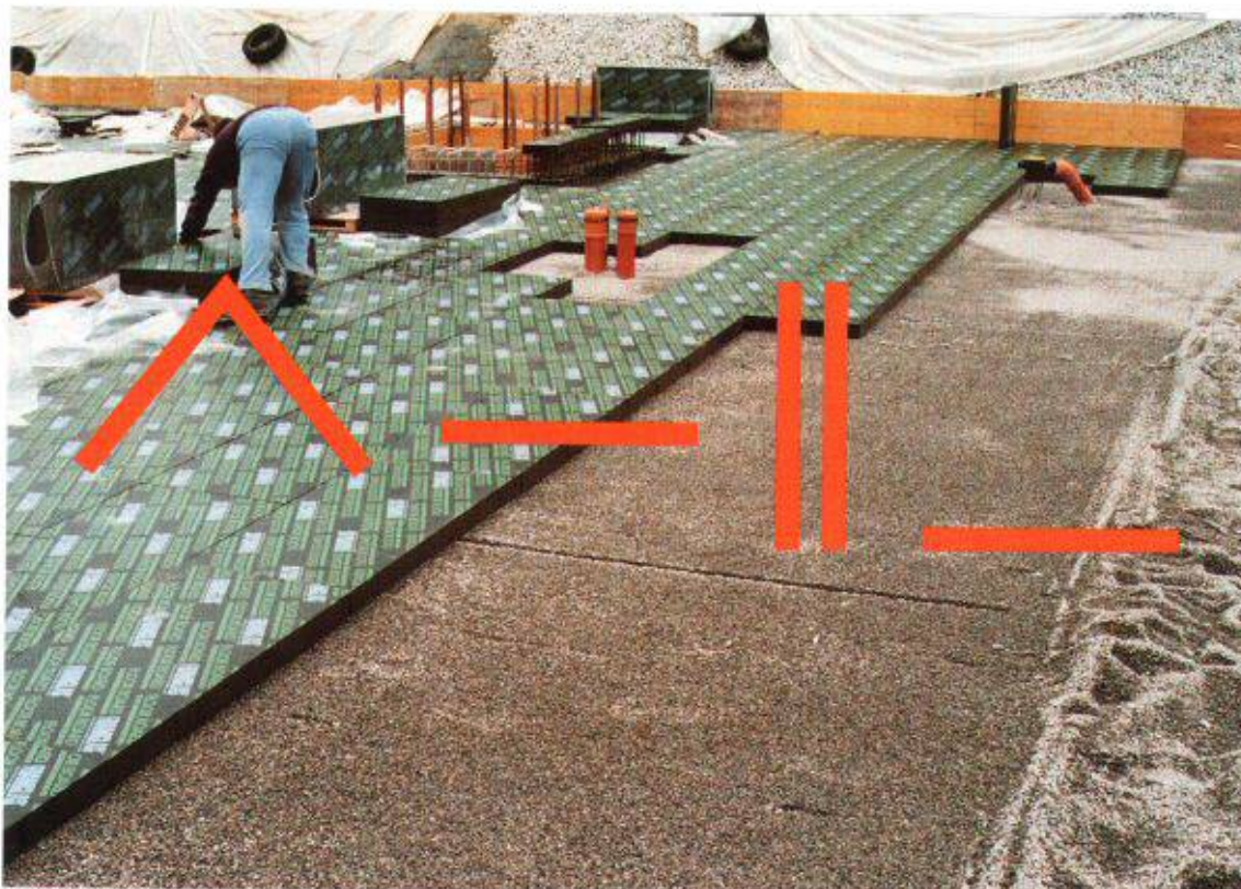
FOAMGLAS®-FLOOR BOARD, eine Weiterentwicklung von Pittsburgh Corning für die Bodendämmung in trockenbauweise (im Bild die Verlegung von FOAMGLAS®-FLOOR BOARD auf Feinkiesplanie unter der Bodenplatte eines Schulgebäudes).
