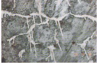
Bild 6. Aussinterungen bei wasserführenden Rissen
