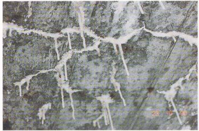
Bild 6. Aussinterungen bei wasserführenden Rissen
