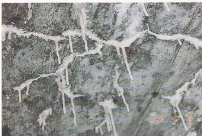
Bild 6. Aussinterungen bei wasserführenden Rissen
