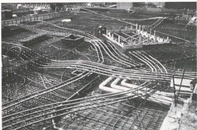
Bild 4. Vorgespannte Abfangdecke
