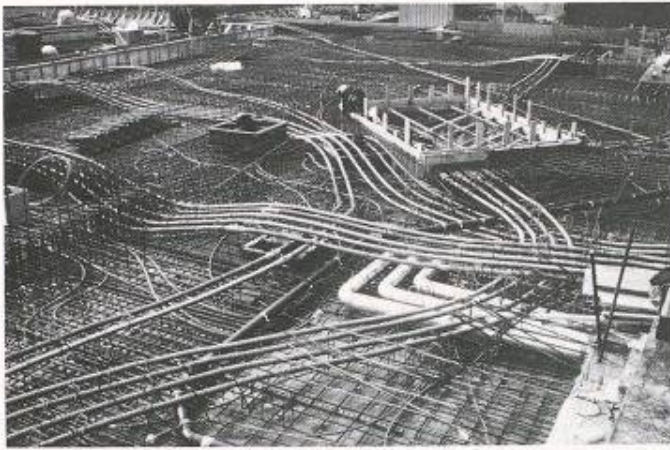
Bild 4. Vorgespannte Abfangdecke
