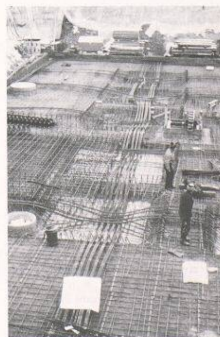
Bild 6. Vorgespannte Fundamentplatte
