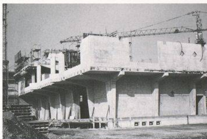
Bild 14. Vorgespannte Winkelstützen zur Unterstützung der Auskragung
