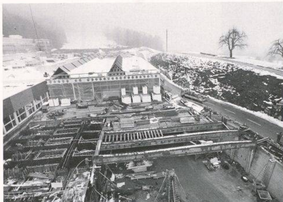
Bild 8. Baustelle mit bereits versetzten Fertigteilträgern
