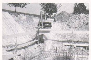
Eine der typischen PE-Anwendungen im Baubereich: Polyethylenfolien schützen Baugruben vor witterungsbedingten Erdrutschen
