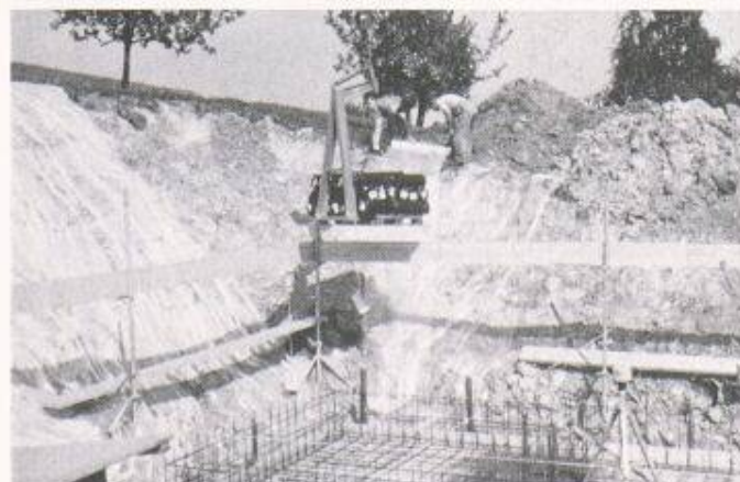
Eine der typischen PE-Anwendungen im Baubereich: Polyethylenfolien schützen Baugruben vor witterungsbedingten Erdrutschen
